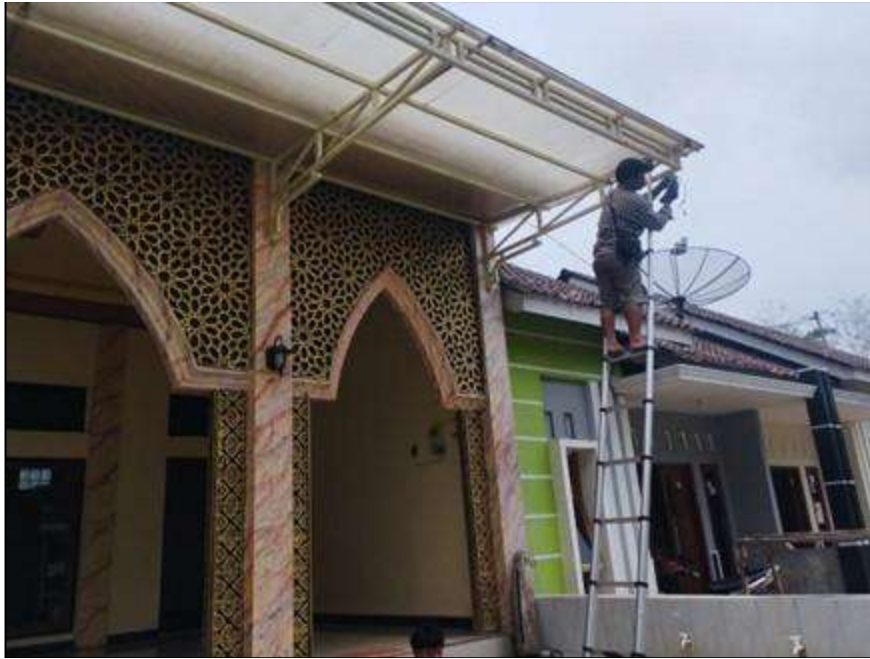
Gambar 1. Proses Pemasangan CCTV
